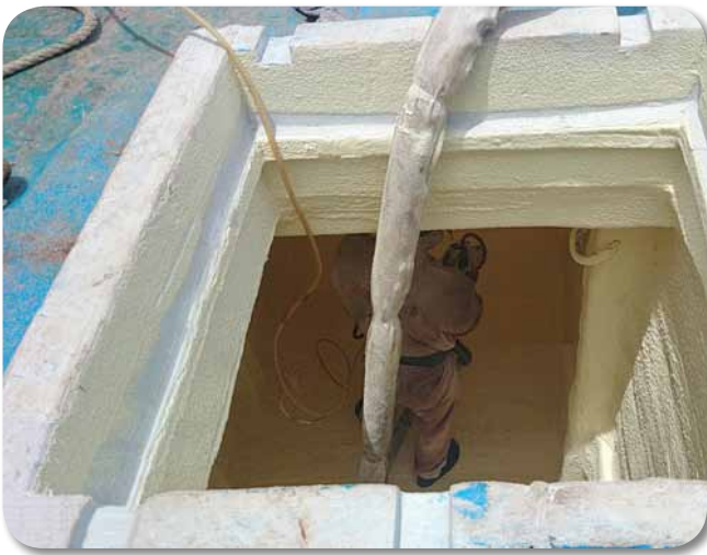
Phun foam tạo lớp cách nhiệt cho hầm bảo quản trên các loại tàu cá.
