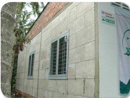
Nhà làm bằng bê tông nhẹ cốt liệu gáo dừa. (Ảnh: Trang thông tin Festival Dừa Bến Tre)
