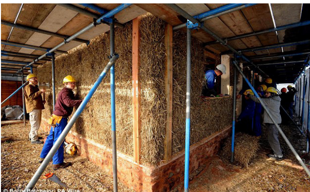
Một ngôi nhà rơm xây dựng ở Somerset (Anh).
