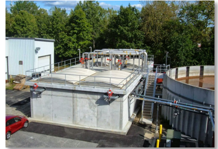
Bể phản ứng sinh học màng yếm khí (AnMBR- anaerobic membrane bioreactor) của Ken's Foods.
