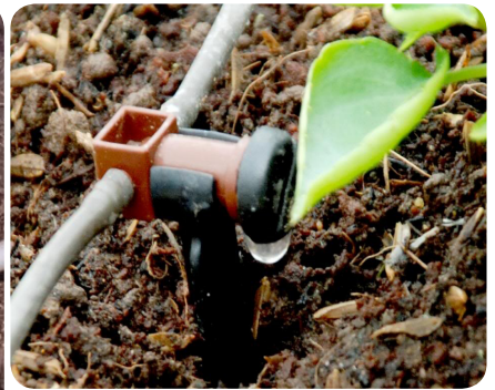
Hệ thống tưới nhỏ giọt hoàn toàn tự động ngày nay
