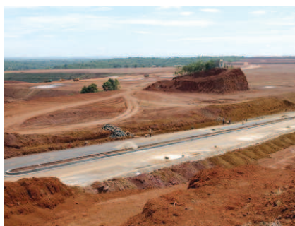
Trên công trường nhà máy Bauxit Nhân Cơ, Đắk Nông
